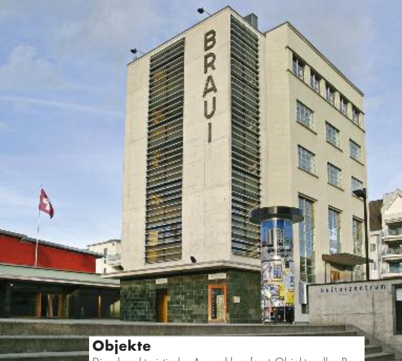
Hochdorf, Sudturm, 1932 Luzern, Lindenstrasse, Sonnerie
