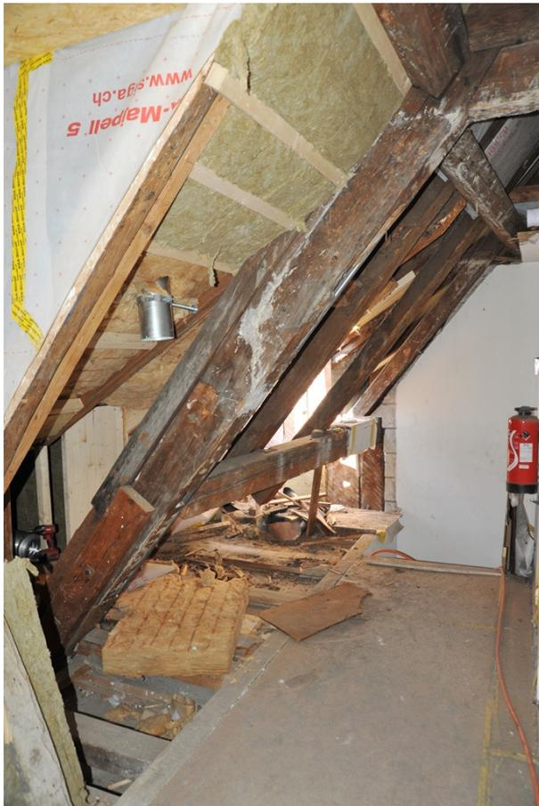
Abb. 46: Südhaus, 1. DG, Raum 402. Querbund Q II im Gefüge von 1611/12 (d), Südansicht. Dahinter setzt das Dachwerk von 1673/74 (d) an, das mit seinen Zwischenpfetten mit dem älteren Querbund Q II verbunden ist (vgl. Abb. 2, Abb. 3, Pfetten-Positionen P1 u. P2).
