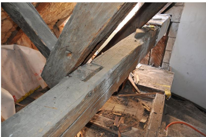
Abb. 48: Südhaus, 2. DG, Raum 402. Untere Zwischenpfette im Dachwerk von 1673/74 (d) (vgl. Abb. 2, Pfetten-Position P1). Blick Richtung Norden. In den Sparrenauflegern sind die Anschlüsse der ehemaligen Kehlbalken zu erkennen.
