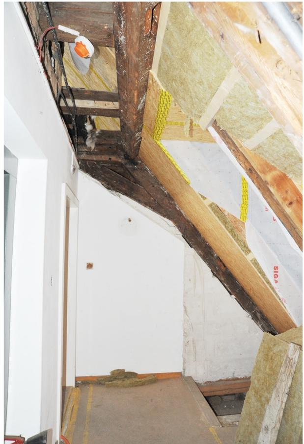
Abb. 47: Südhaus, 1. DG, Raum 402. Querbund Q III im Gefüge von 1611/12 (d), Nordansicht.
