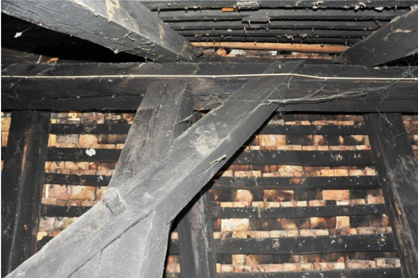
Abb. 40: Nordhaus, 2. DG, Raum 401. Verbindung von Stuhlständer, Firsträhm und Steigband im Gefüge von 1485/86 (d), Nordansicht.
