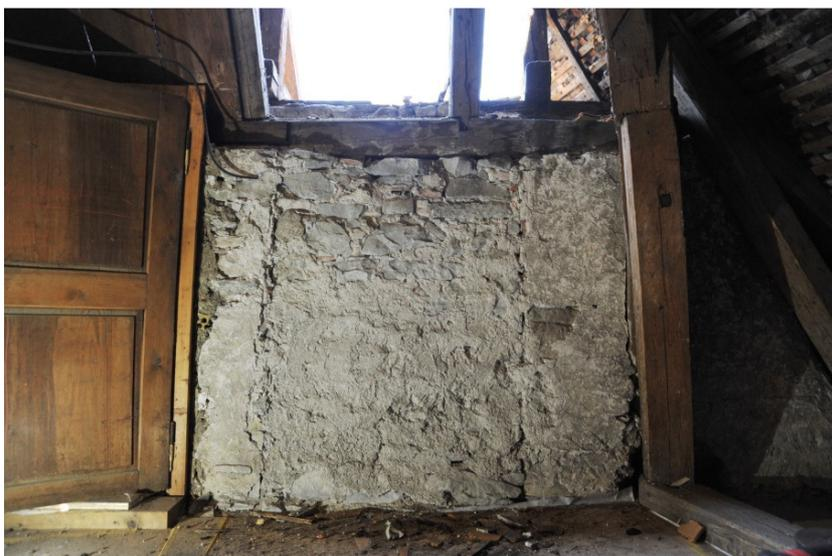
Abb. 31: Nordhaus, 1. DG, Raum 305. Teilansicht der Westwand. In der Mauer zeichnet sich eine ehemalige, 120 cm breite Fensteröffnung ab. Sie wurde in Zusammenhang mit der Aufstockung des Westanbaus 1842 zugemauert.
