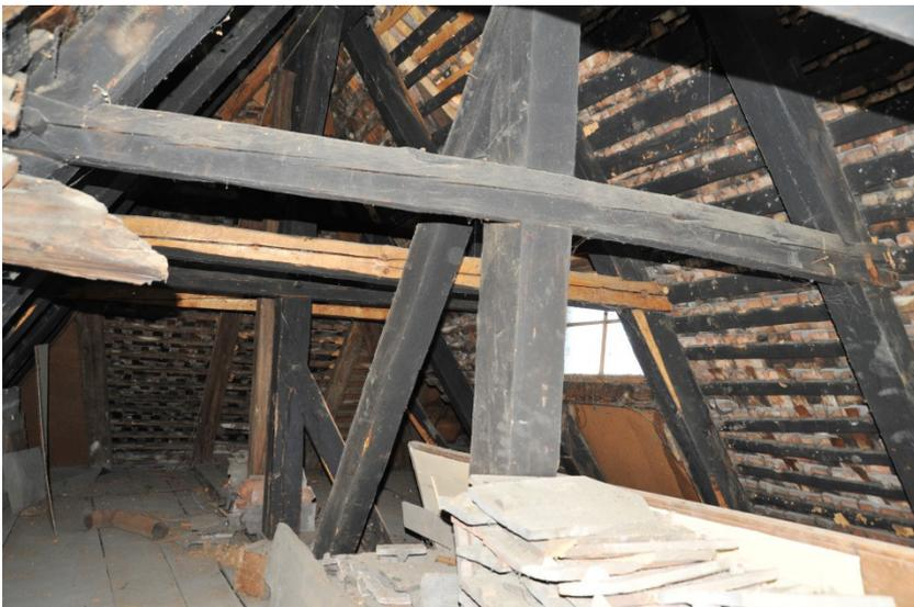
Abb. 41: Nordhaus, 2. DG, Raum 401. Stuhlständer mit überblattetem Kehlbalken im mittigen Querbund des Gefüges von 1485/86 (d), Westansicht.
