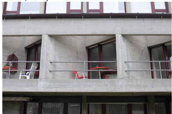
Detailansicht Westfassade Angestelltentrakt (Foto Michael Hanak, 2016)
