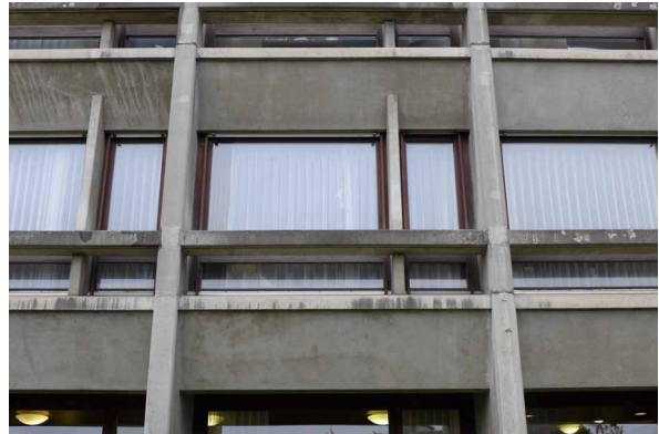
Detailansicht Fassade Hauptbau (Foto Michael Hanak, 2016)
