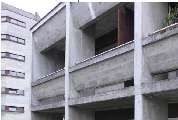
Detailansicht Ostfassade Angestelltentrakt (Foto Michael Hanak, 2016)
