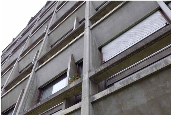
Detailansicht Fassade Hauptbau (Foto Michael Hanak, 2016)
