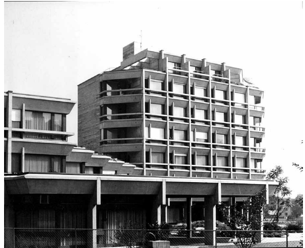
Foto ca. 1968 (Archiv Rüssli Architekten, Luzern)
