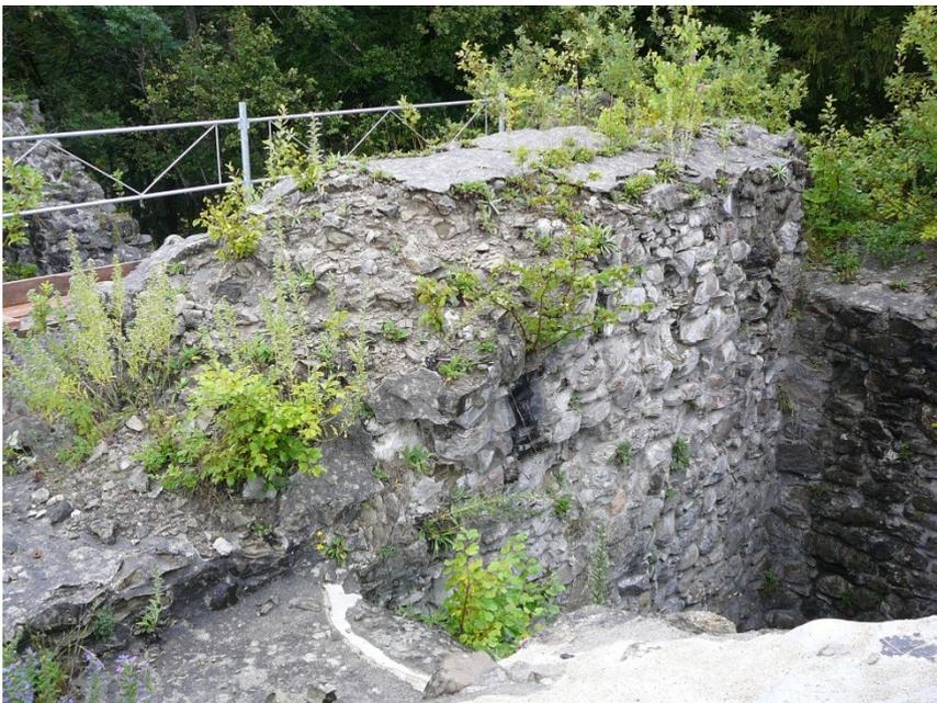
Vor Restaurierungsbeginn: Stark zersetzte bis fehlende Abdeckung der Mauerkrone, intensiver Bewuchs. Regenwasser dringt ungehindert ins Mauerwerk ein. (Foto Kantonsarchäologie)
