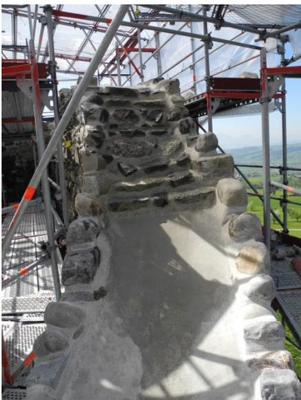
Die fertig ausgeformte Mauerkrone garantiert eine schnelle, vollständige Ableitung des Regen- und Schmelzwassers. (Foto Kantonsarchäologie)
