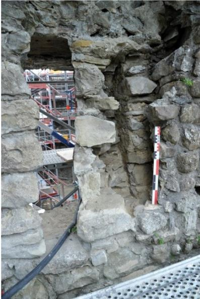
Die Bauforschung dokumentiert die zutage tretenden Spuren der Bau- und Nutzungsgeschichte: Im Bild ist nach der Entfernung schadhafter Partien des Mauerwerks deutlich eine alte Fensterleibung erkennbar (rechts beim Massstab). In einer Umbauphase ist das Fenster zu einer Scharte (links) verkleinert worden. (Foto M. Prohaska)
