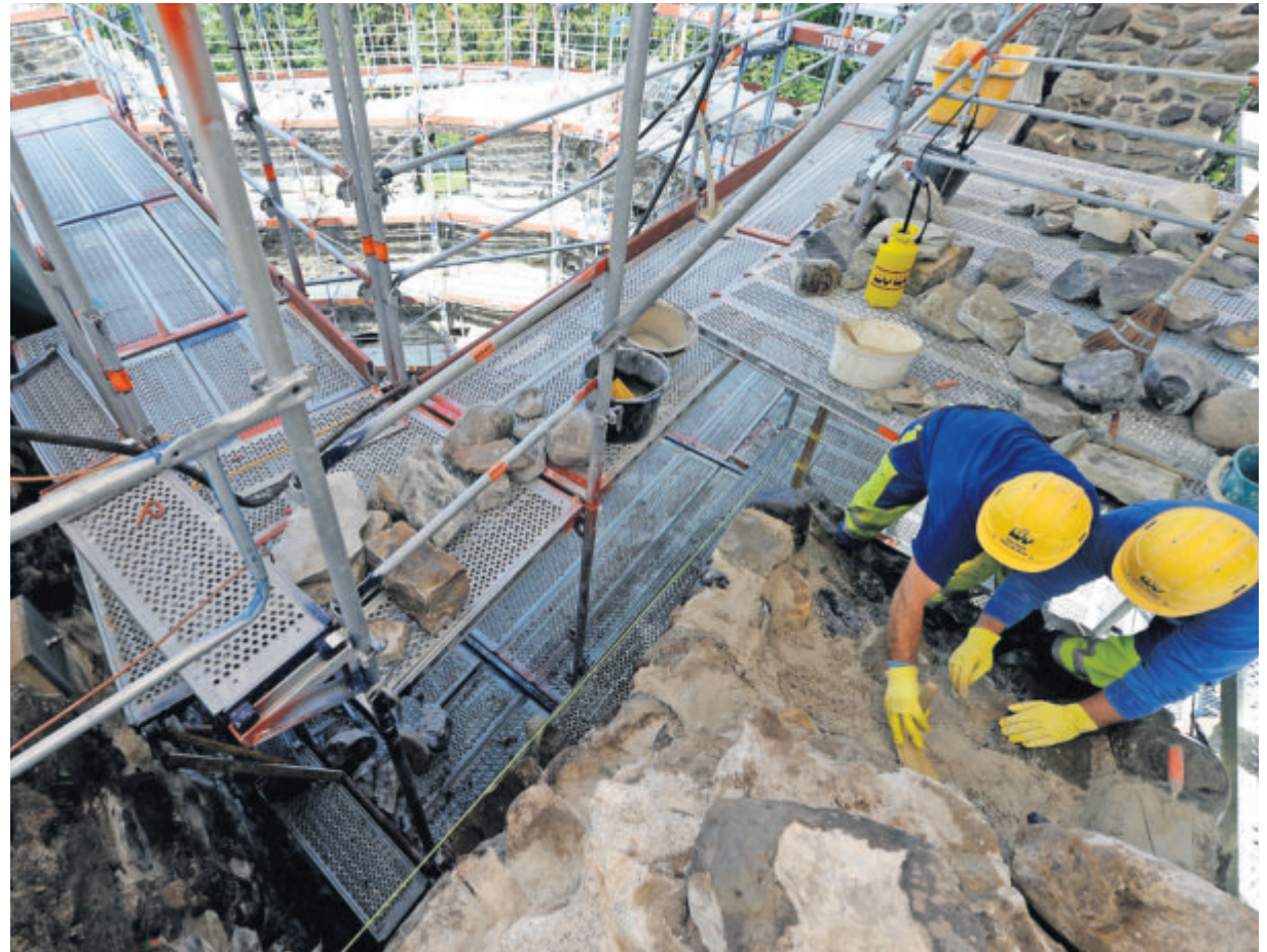
Aufwendige Restaurierung: Arbeiter gestern auf der Burgruine Nüegg in Lieli.
