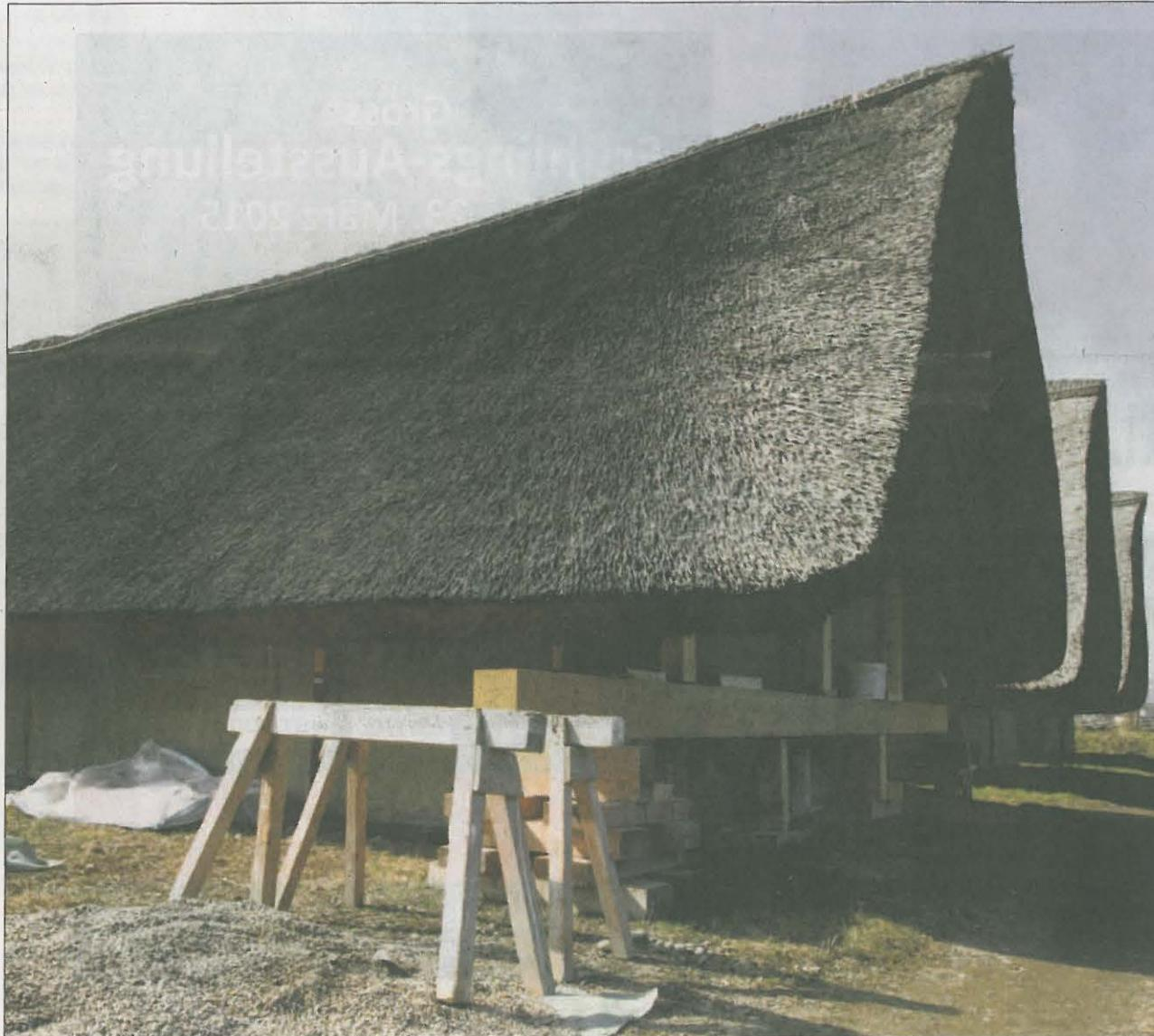
Die Häuser müssen abgestützt werden, damit die dringend nötigen Bauarbeiten ausgeführt werden können. Bis Ende März ist eine erste Sanierungsetappe geplant – dann ist Saisonbeginn und das Pfahlbauerndorf wieder für die Besucher bereit. FOTO ANA
