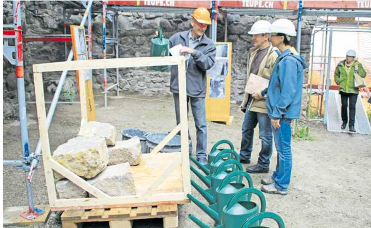
Bauprojektleiter Lukas Högl demonstriert die Wassersättigung in einem Kubikmeter Mauer vor der Sanierung. Fotos kae
